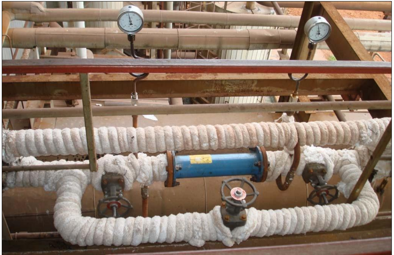
Figura 2 Instalación del aparato de homogenización en la caldera N°5
