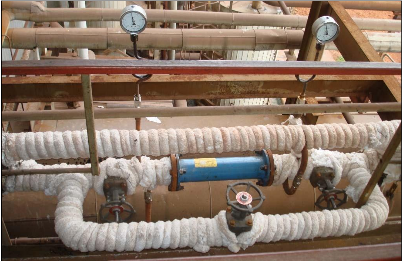
Zeichnung 2 Aufstellung des Homogenisators auf dem Kessel Nr. 5
