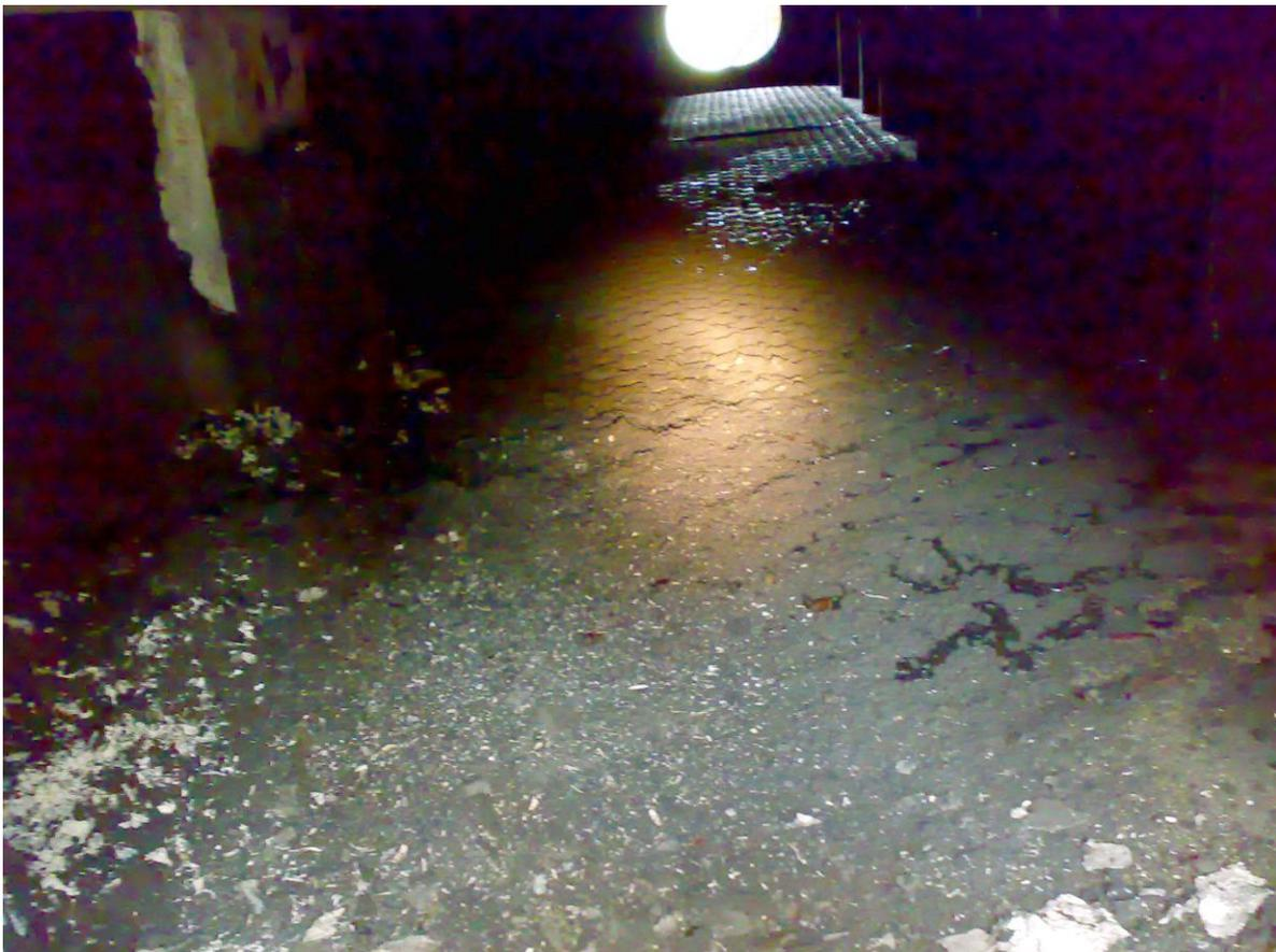
*Тот участок воздухоподогревателя где проходил поток менее увлажненных уходящих газов там трубки абсолютно чистые.*
