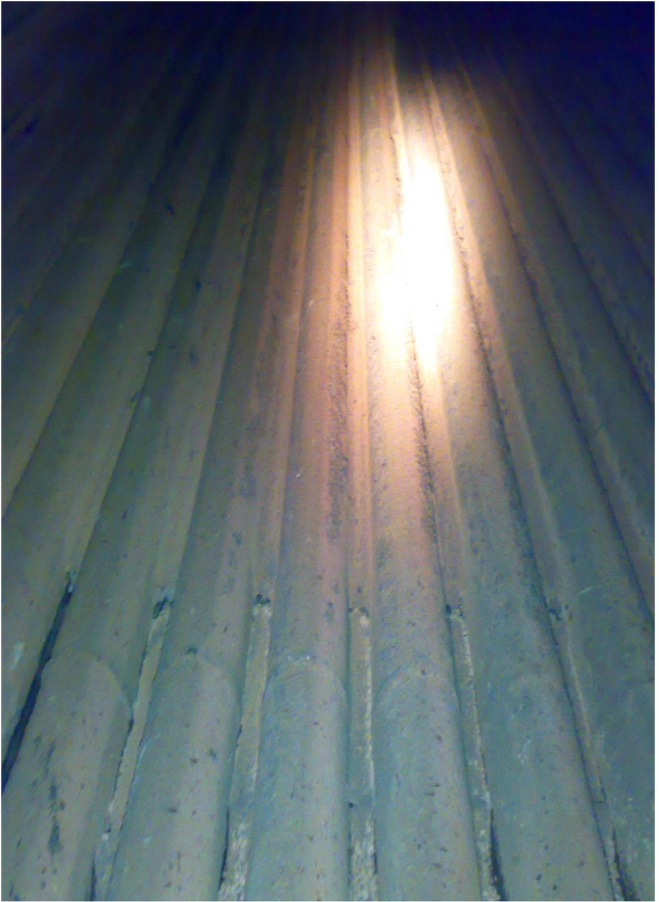
*Не наблюдается ошлакования на ширмовом пароперегревателе (зона высоких температур на выходе из топки)*
