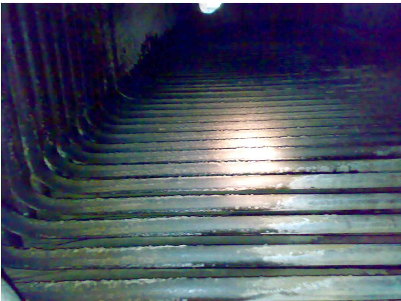
*Если бы у нас не появились свищи в паровом предварительном подогревателе воздуха и пароперегревателе котел бы мог стабильно продолжать работу и дальше на этом ужасном грязном топливе. Влага из паровых утечек попала в газовый тракт котла что привело к коагуляции зольных частиц которые в большом количестве отложились в рекуперативном воздухоподогревателе и забили газовый тракт.*
