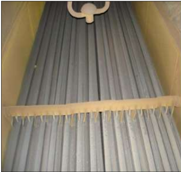
Рисунок № 14 Трубчатый воздухоподогреватель
