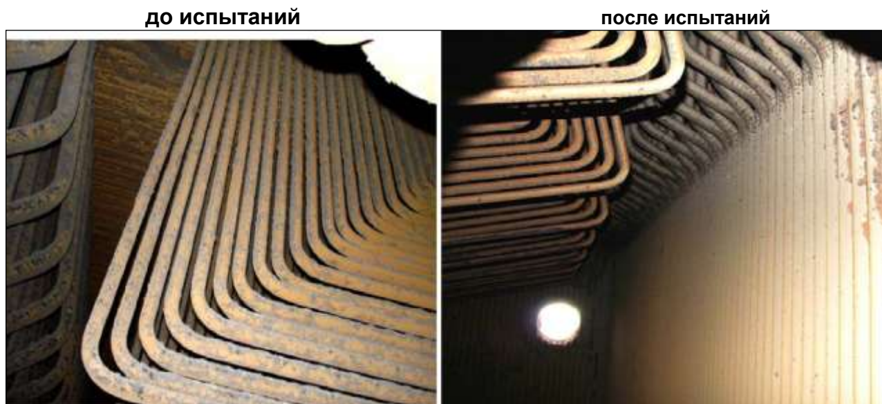
Рисунок № 12 ширмовый пароперегреватель
