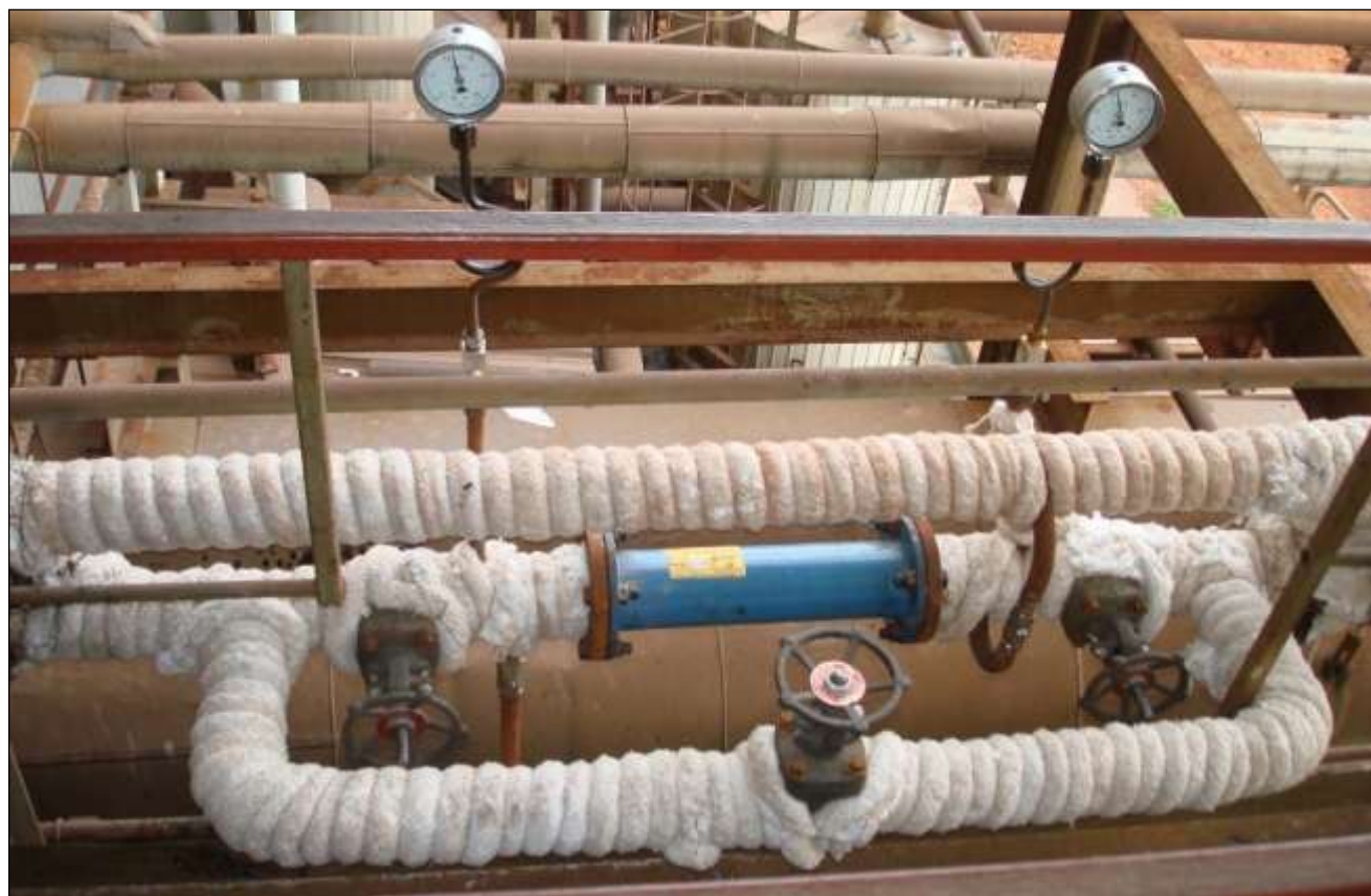
Рисунок №2 Установка гомогенизатора на котле №5
