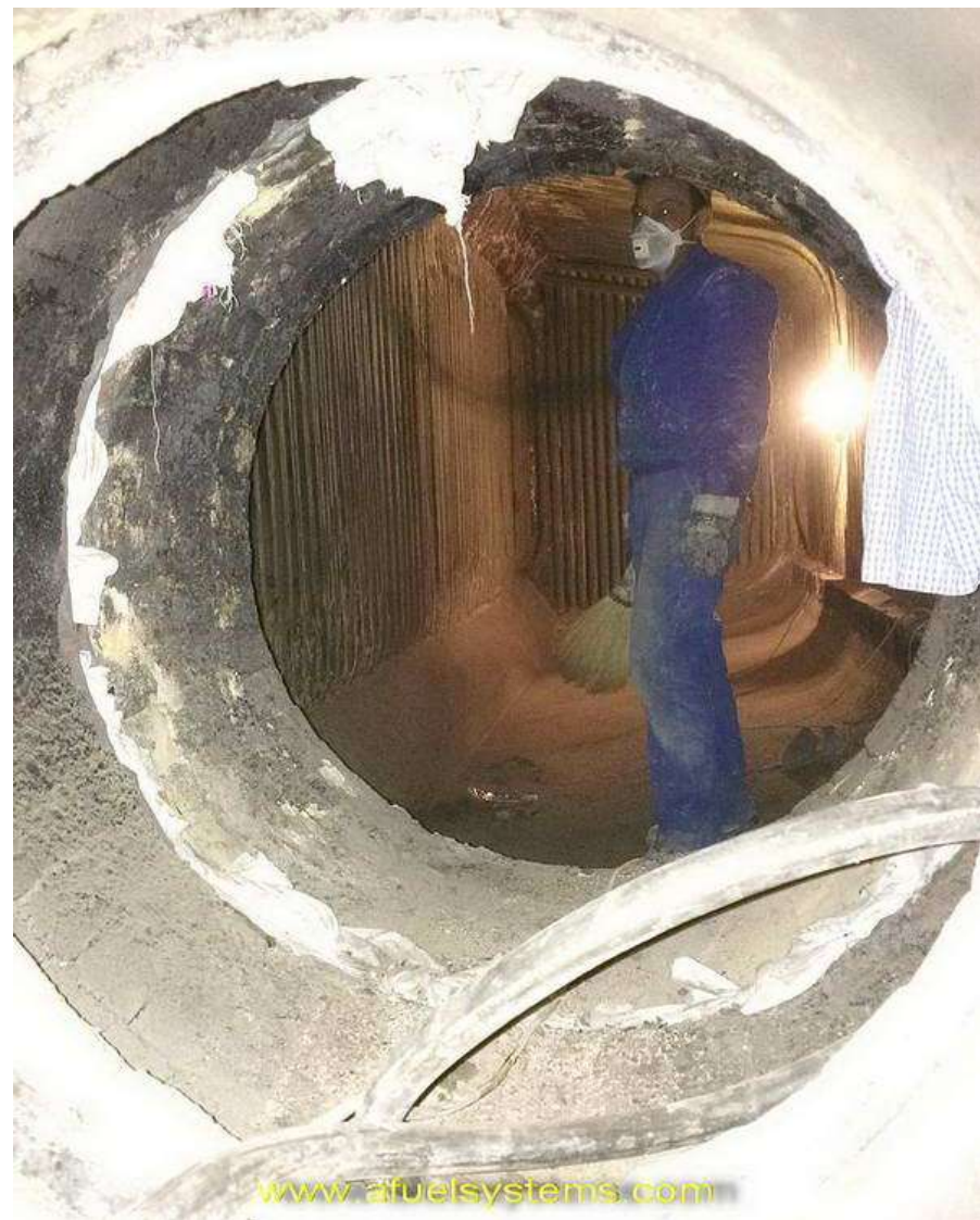
Чистка котла после – обстукивание и удаление веником.
